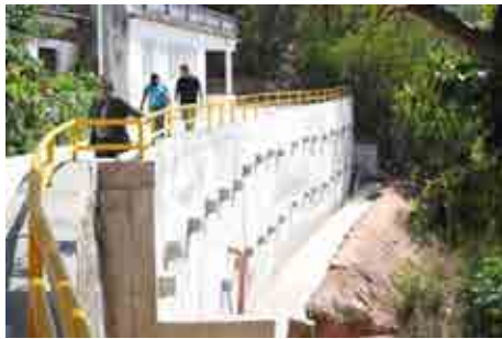
Contenção de encosta
