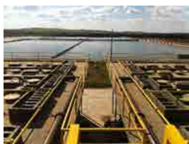
Estação de Tratamento de Esgoto de Lagoa da Prata/MG
