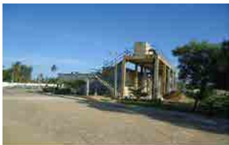
Vista da ETE ERQ Oeste
