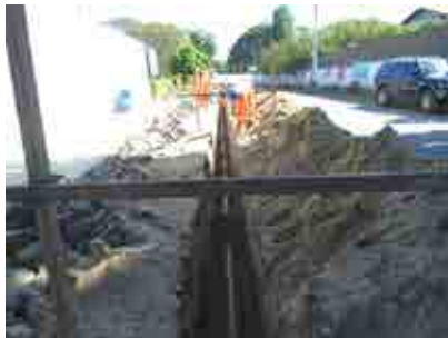
Bacia CD-02 – Implantação de Rede Coletora
