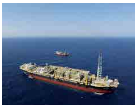
FPSO Cidade de São Paulo em operação
