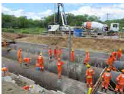
Assentamento de tubulação
