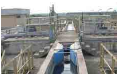
ETE Cubatão – Unidade de Tratamento Preliminar
