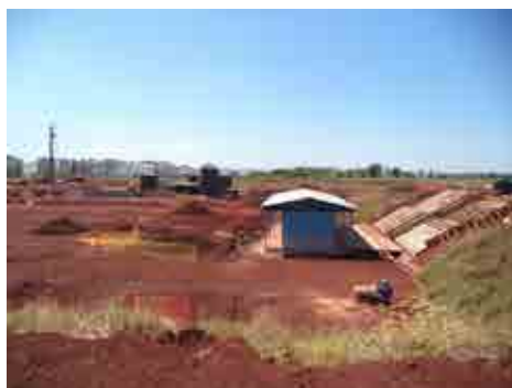
UFN V – Canteiro de obras
