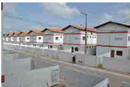
Unidades habitacionais em Jaderlândia
