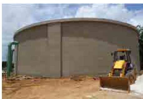
Construção do reservatório R14 em Salvador
