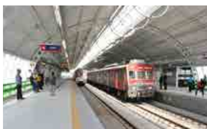
Estação Santo Afonso
