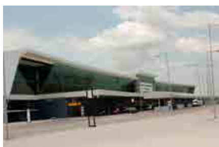
Reforma e ampliação do TPS
