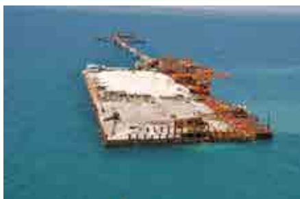
Ampliação do Terminal Salineiro de Areia Branca
