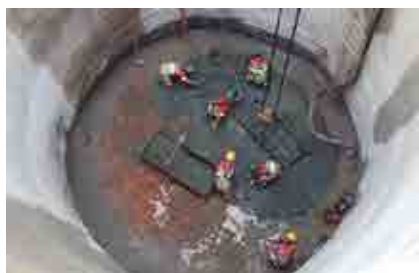
Vertente 2: Travessia - Execução do PV 3T
