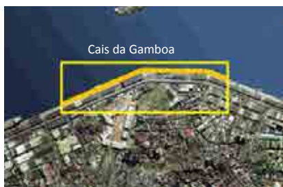
Vista aérea Porto do Rio
