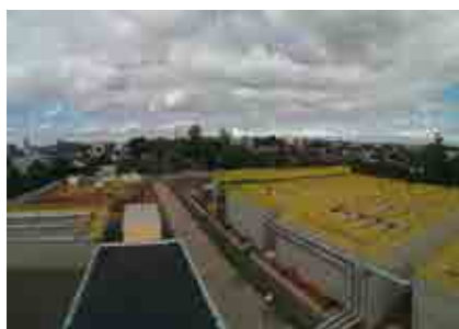
ETE Esteio – SES Esteio/Sapucaia Vista Geral
