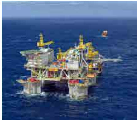
Plataforma P-61 na locação
