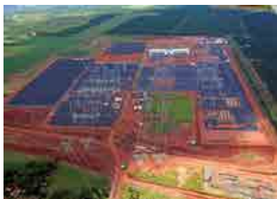
Vista aérea da SE Araraquara II
