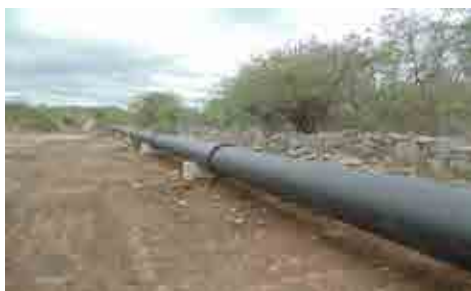
Assentamento de adutora ferro dúctil
