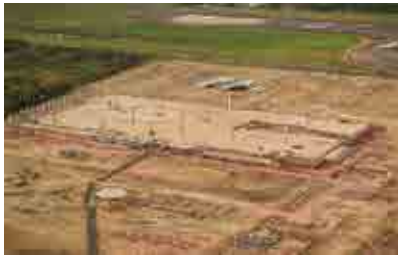
Construção do novo Terminal de Cargas
