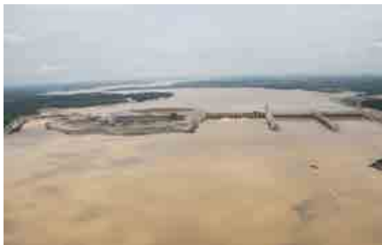
Vista geral de jusante
