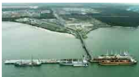
Alargamento do Berço 302 – Construção Pier 400
