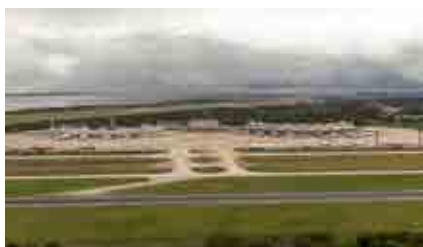
Recuperação e revitalização dos Sistemas de Pistas e Pátio
