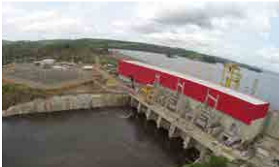
Casa de Força
