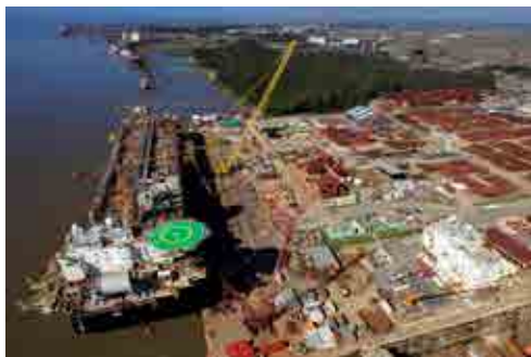
Lançamento do casco do FPSO P-66
