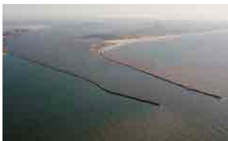
Vista aérea da obra
