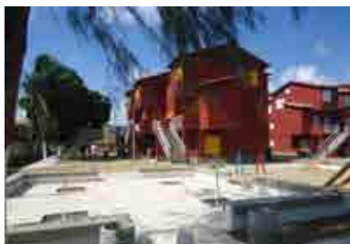
Unidades habitacionais – Terreno II
