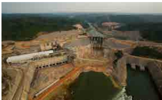
Vista Geral da Usina
