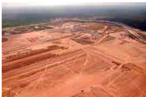
Terraplenagem da Refinaria Premium I
